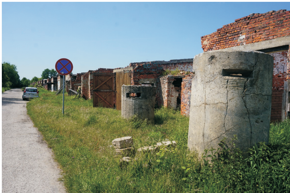
Fot. 6. „Części baraków z cegły” w okolicy Alte Judenrampe
